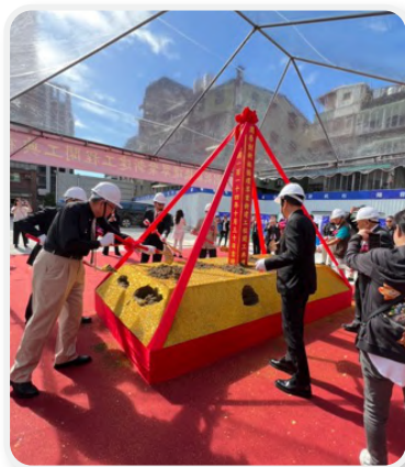
板橋環翠段新建工程開工說明會
