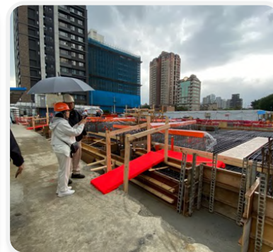
Floor Slab Pouring Tour (GRAND MAISON RUENTEX)
