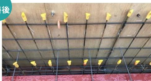
已於鋼筋綁紮前將梁底木屑清理
