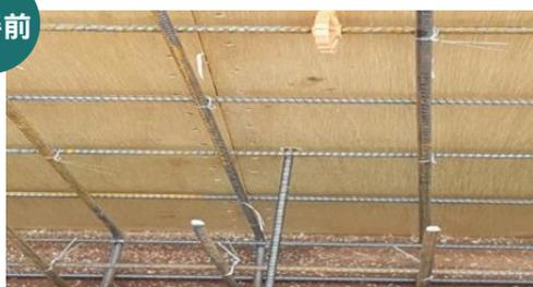
倒吊牆模板屑於鋼筋綁紮前先清理
