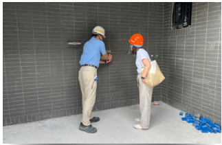
室內給水管試壓參觀
