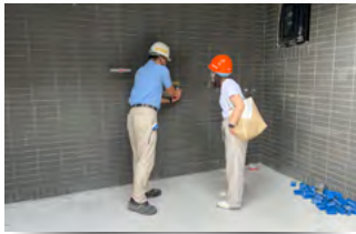
室內給水管試壓參觀
