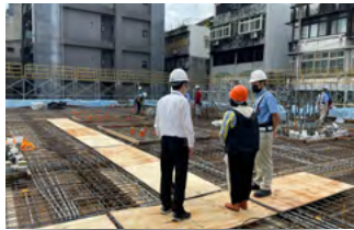
Floor Slab Pouring Tour
