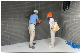
室內給水管試壓參觀
