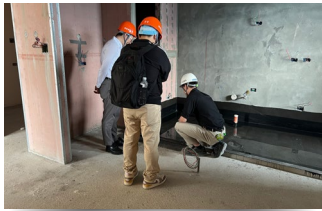
浴廁廚房防水試水參觀
